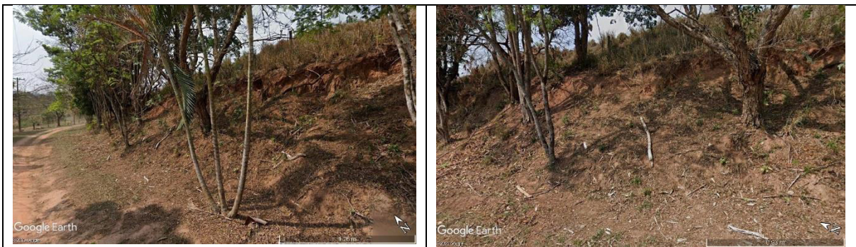
Fotos 4.2-3 e 4.2-4: Taludes de corte sem cobertura vegetal e diversos processos erosivos sobre os mesmos, no ano de 2021 (Street View Google).
