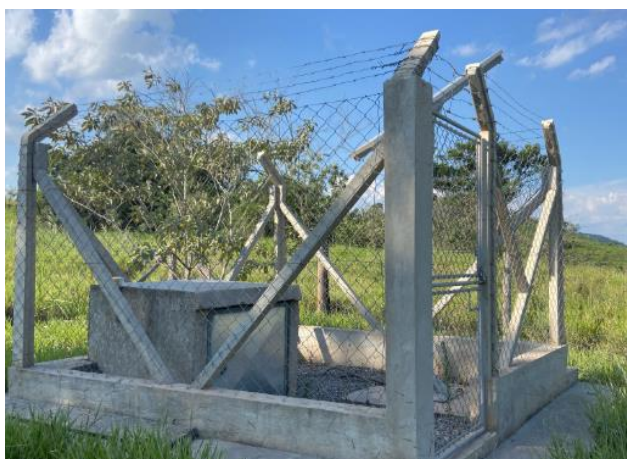
Foto 1 – Estação sismológica da Barragem Duas Pontes (Data:16/02/2023)
